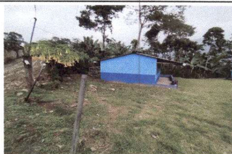
FOTO 4: Reparación de tubo hg y malla galvanizada
