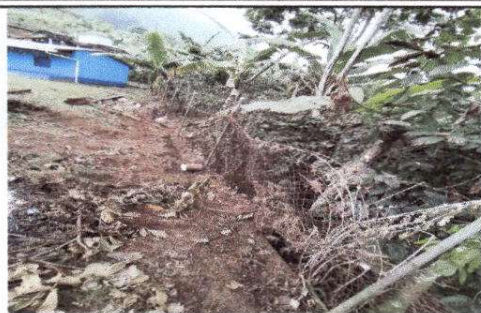
FOTO 1: Reparación de tubo hg y malla galvanizada
