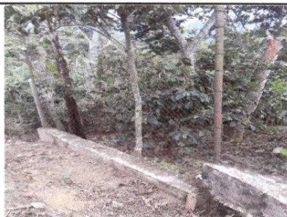
FOTO 3: Reparación de tubo hg y malla galvanizada
