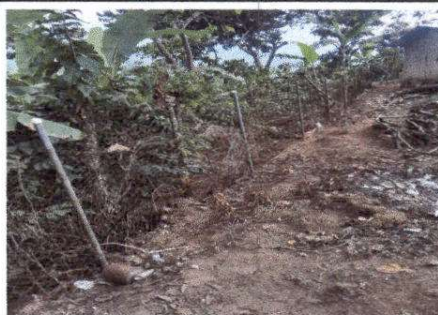
FOTO 2: Reparación de tubo hg y malla galvanizada
