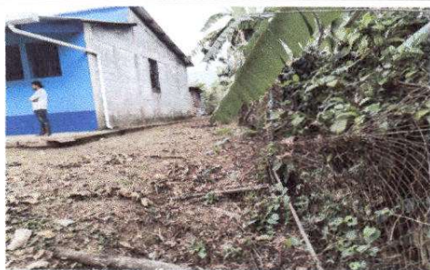
FOTO 5: Reparación de tubo hg y malla galvanizada
